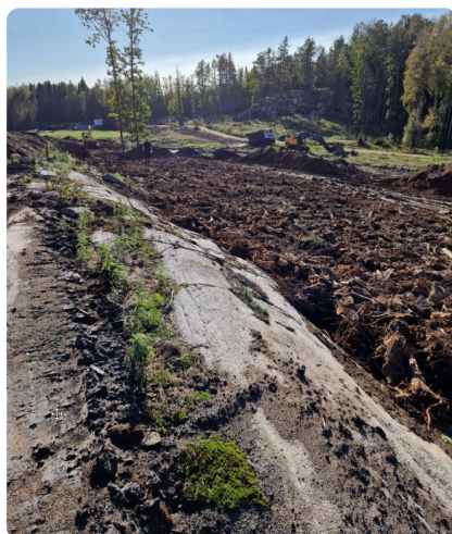
Figur 7: Woodstore Pilot 1. Bildet til venstre viser biomassen etter at kammeret er fylt opp. Bildet til høyre: Kammeret er ferdig etablert, med 1 meter leire direkte på biomassen, 0.5 meter overdekning med jord og frukttrær plantet på toppen.
